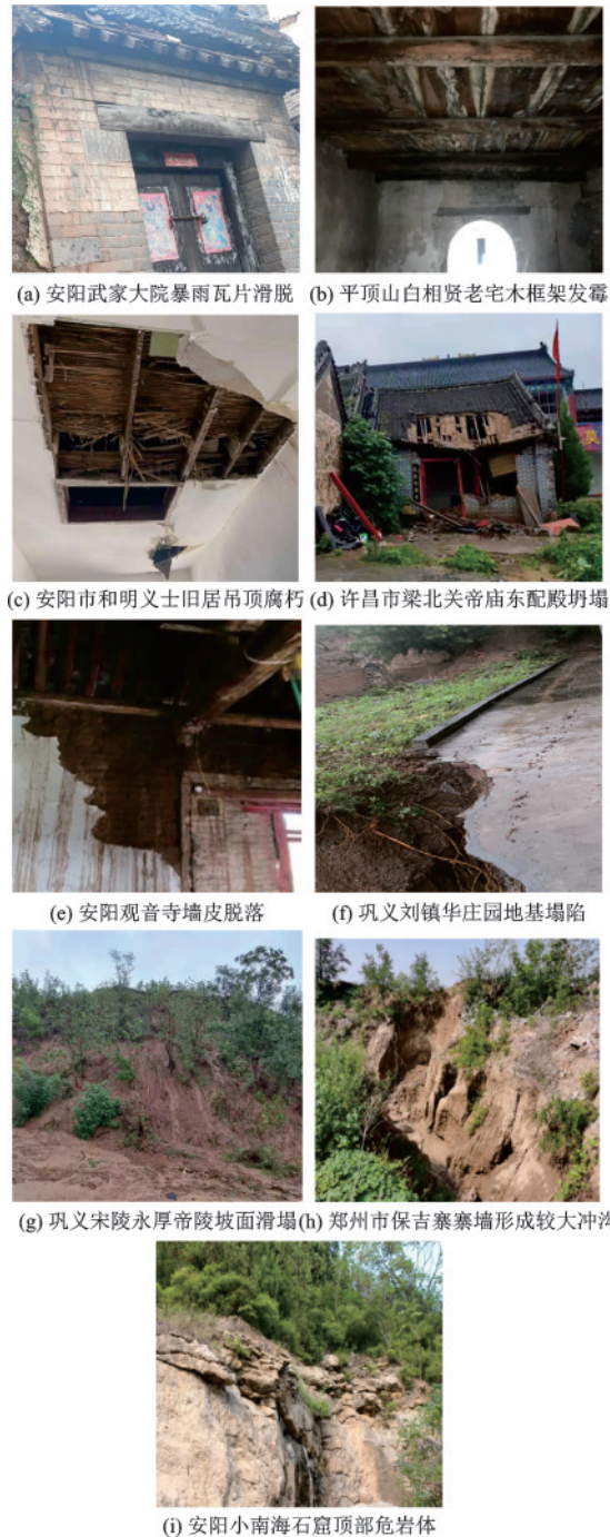
图3 暴雨冲刷破坏典型案例
