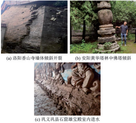
图4 积水浸泡破坏典型案例
